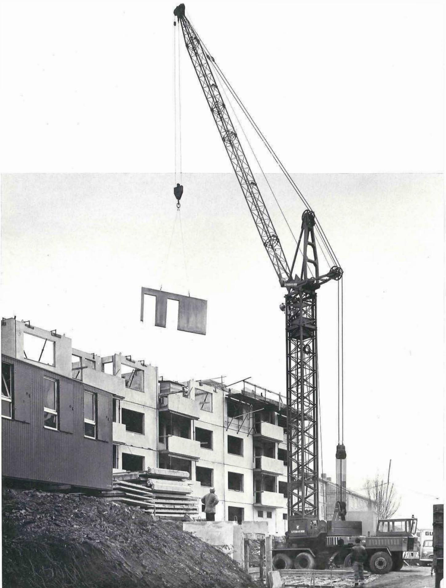
LIEBHERR-Autokran AUK 80 in Turmdrehkran-Ausführung mit Nadelausleger eingesetzt in der Fertigteil-Bauweise. Die Tragkraft von 3 t bei 26 m Ausladung ließ sich bei dieser Baustelle voll ausnützen. Durch die Verfahrbarkeit in Arbeitsstellung ohne Last wurden die Bauzeiten verkürzt, da die Bauelemente bei der nahegelegenen Feldfabrik abgenommen wurden. Weitere Transportmittel waren nicht erforderlich.
