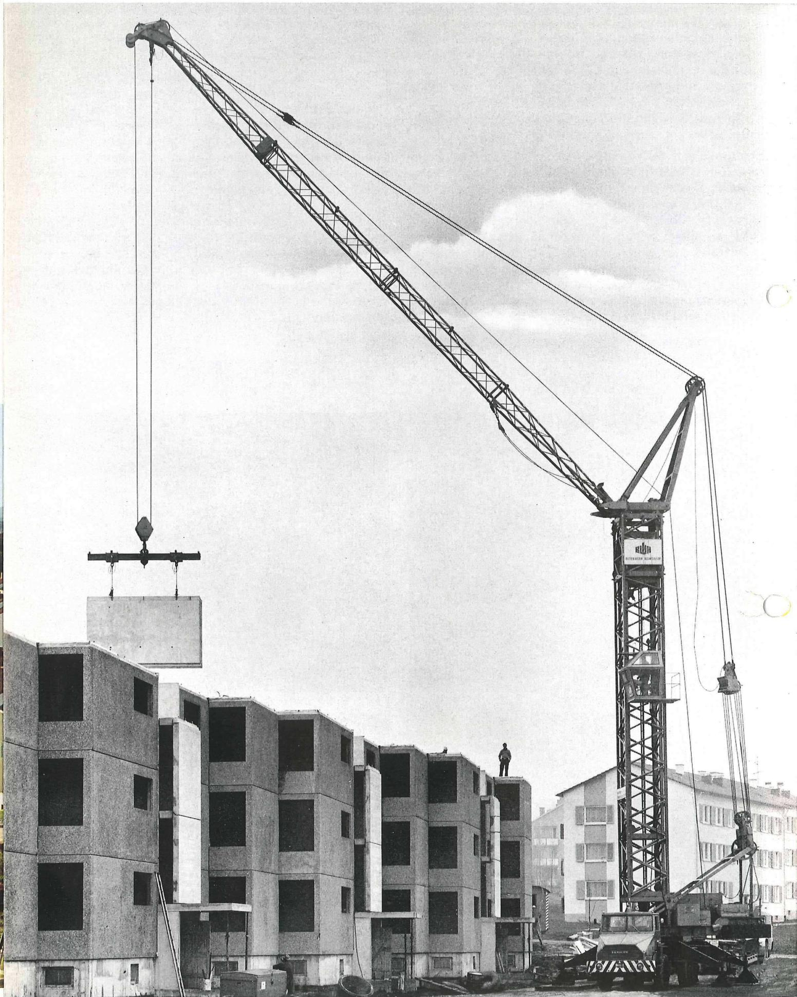
Hubwerksmotors und somit eine erhöhte Hubgeschwindigkeit von 180 m/min beim Einzelseil zu erreichen.
