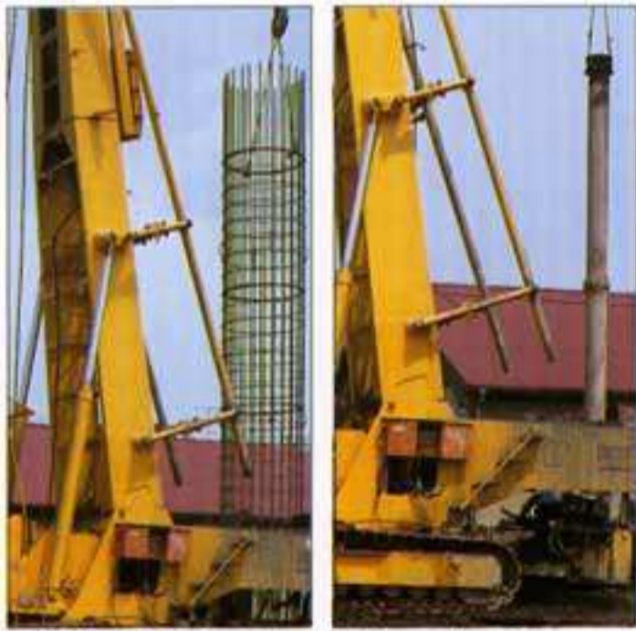
● 鉄筋の建込み
