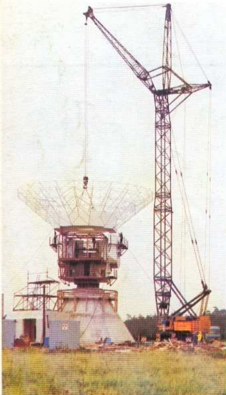
GOTTWALD AK 210-73 mit 180/210 t Tragfähigkeit
