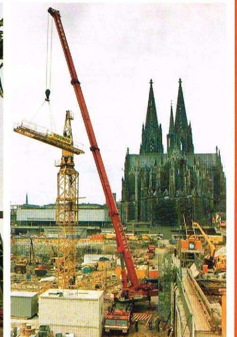
GOTTWALD AMK 200-83, 200/230 t Tragfähigkeit
