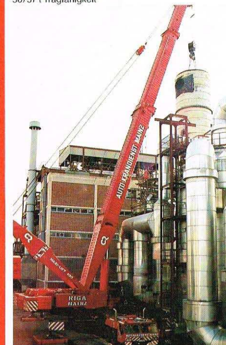
GOTTWALD AMK 400-93, 400/500 t Tragfähigkeit
